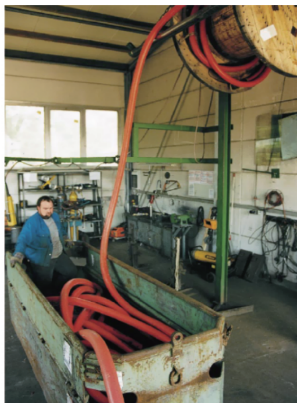
图1: 将电缆以“8”字形放入地下运输箱中
